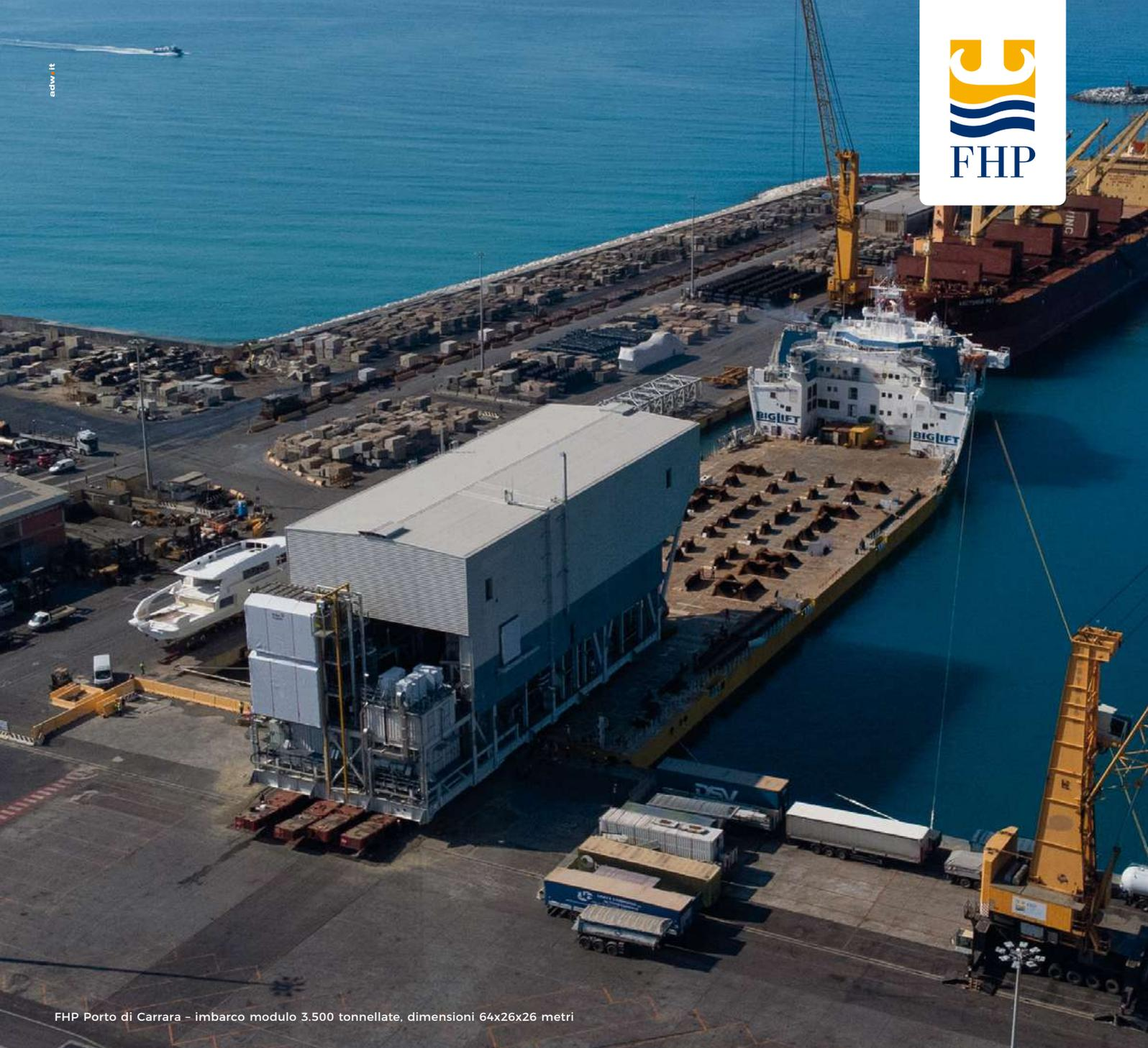
FHP Porto di Carrara - imbarco modulo 3.500 tonnellate, dimensioni 64x26x26 metri
